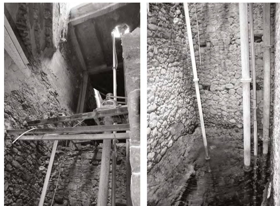
Photo 1 : Tiout et sa nappe phréatique visible en 2018 avec un puits monumental creusé au cours du XX e siècle pour accompagner le rabattement, un patrimoine banalisé et oublié (© Photo : T. Ruf)
